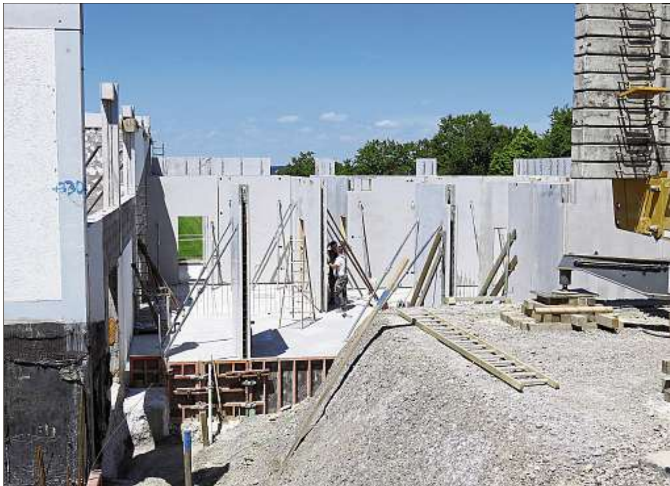
An der Turnhalle Isingen sind derzeit schon die Fertigteile für den Nebentrakt aufgestellt.
